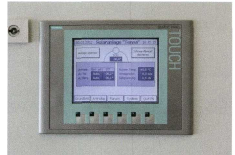
Mit dem Simatic KTP 600 Basic Touch Panel PN lassen sich die Solar-Wings auch jederzeit manuell steuern
